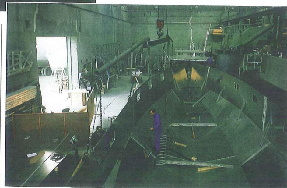
**Vingt-quatre heures séparent la pose du bordé tribord du bordé bâbord de Fleur Australe II. La tôle, en aluminium épais, est suspendue pour faciliter sa mise en place.**
