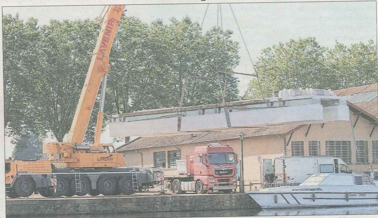
■ La plateforme du bateau de 66 tonnes a été mise à l'eau mardi matin avant le début de l'assemblage.
