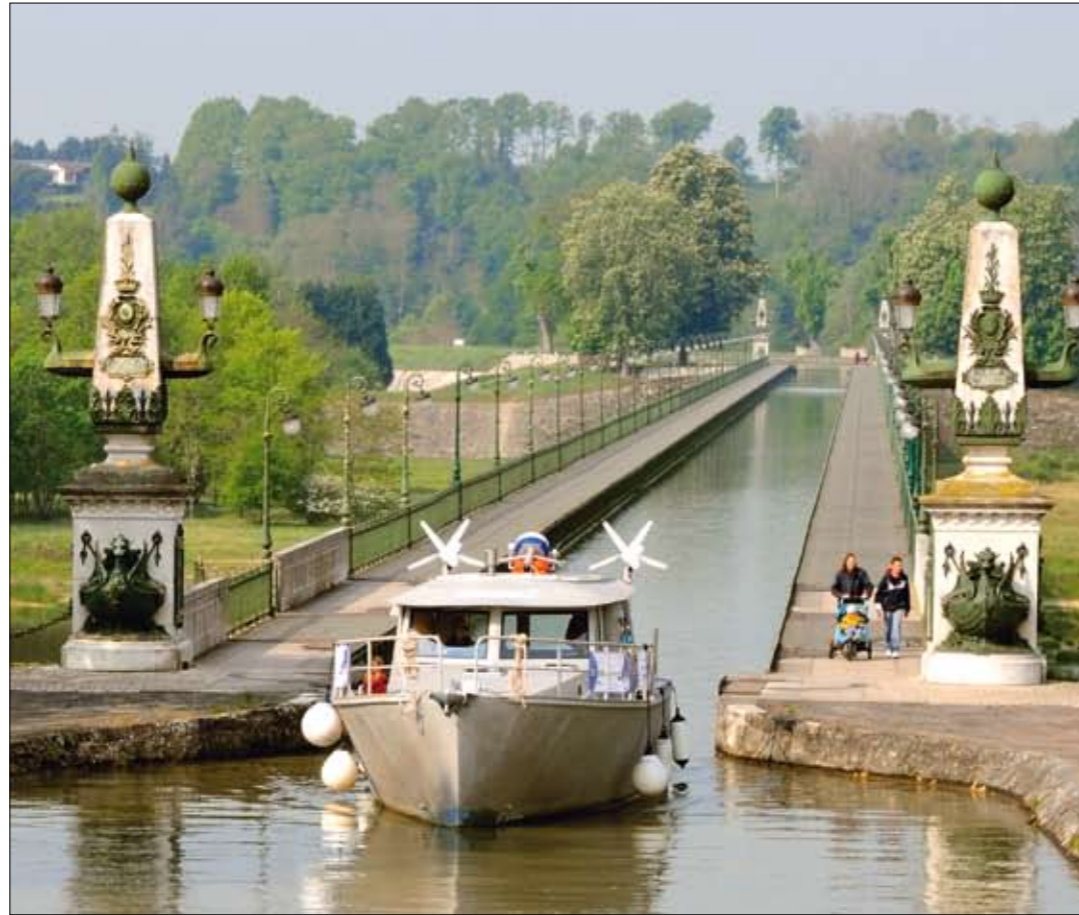
Sur les 640 km effectués entre Lyon et Paris - ici le canal de Briare - 540 km ont été faits exclusivement aux moteurs électriques. Le silence est d'or !
